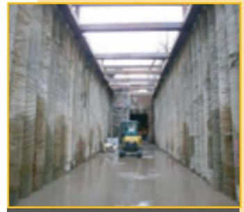
Baugrube mit Bohrfahlwänden
