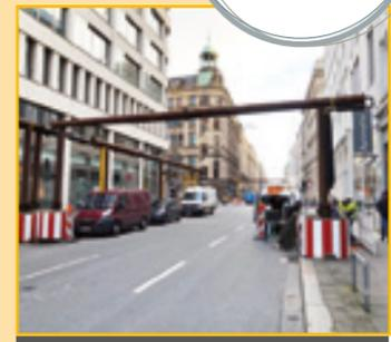
Wasserhaltung mit aufgeständerter Rohrbrücke
